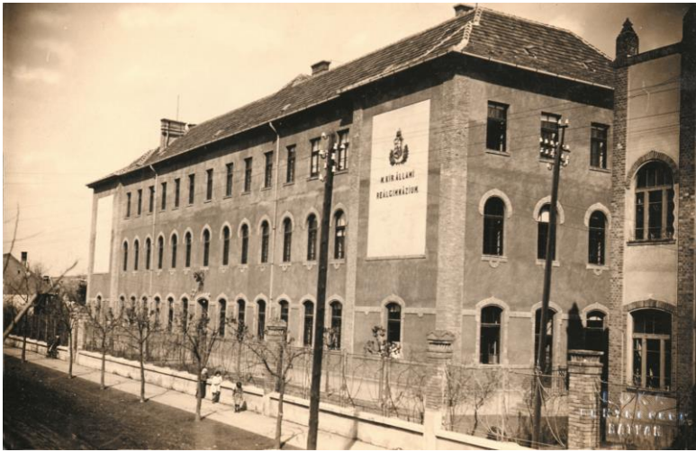
1931-ben emeletet húztak a hajdani szecessziós épületre, és íme az „eredménye”
