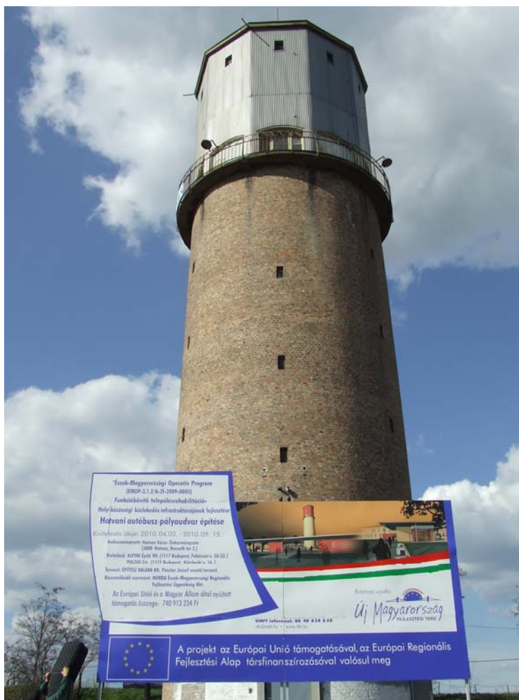
Az 2010. évi felújítás előtt így nézett ki az építmény
