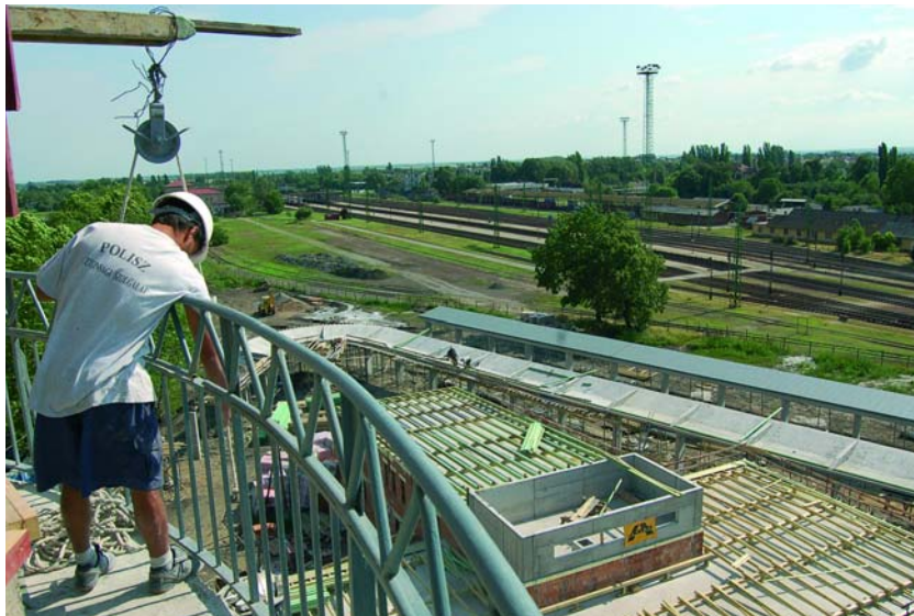
A víztorony zárószintjének felújítása
