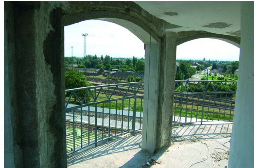
A víztorony zárószintjén lévő árkádok is felújításra kerültek
