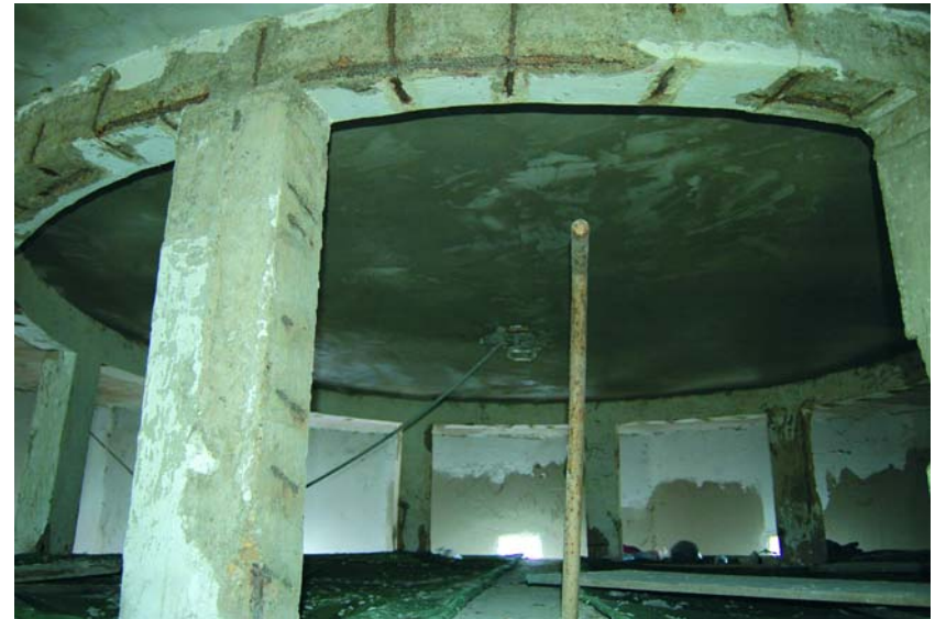
A víztartály felső szintjének felújítása
