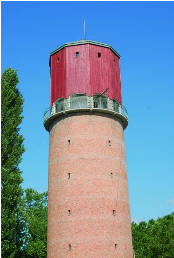
A víztorony fejezete az új faburkolattal
