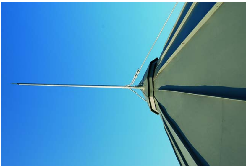
A víztorony elkészült fémlemez borítása a villámhárítóval
