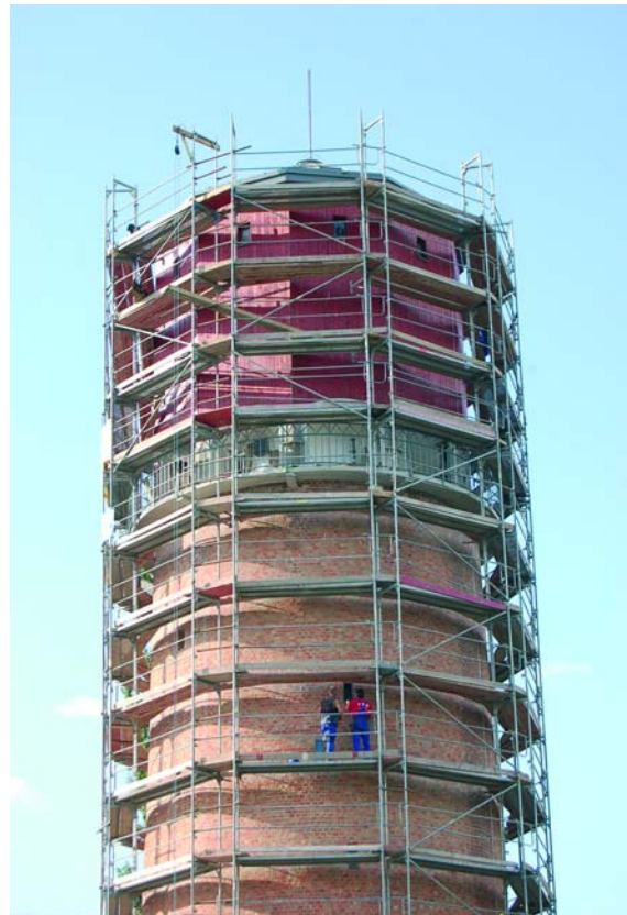
A víztorony téglahomlokzatának tisztítása, javítása
