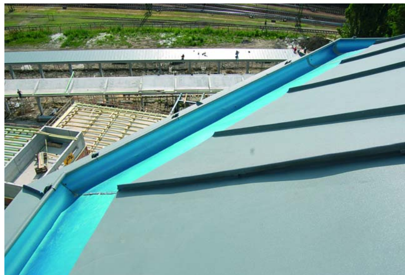
A víztorony új fémlemez fedése rejtett ereszcatorna kialakításával
