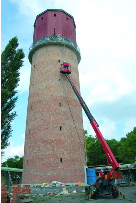
A rögzítőelemek helyének tisztítása, helyreállítása kosaras autóból
