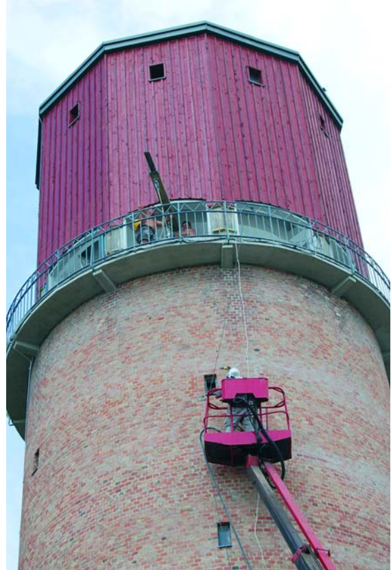
A rögzítőelemek helyének tisztítása, helyreállítása kosaras autóból
