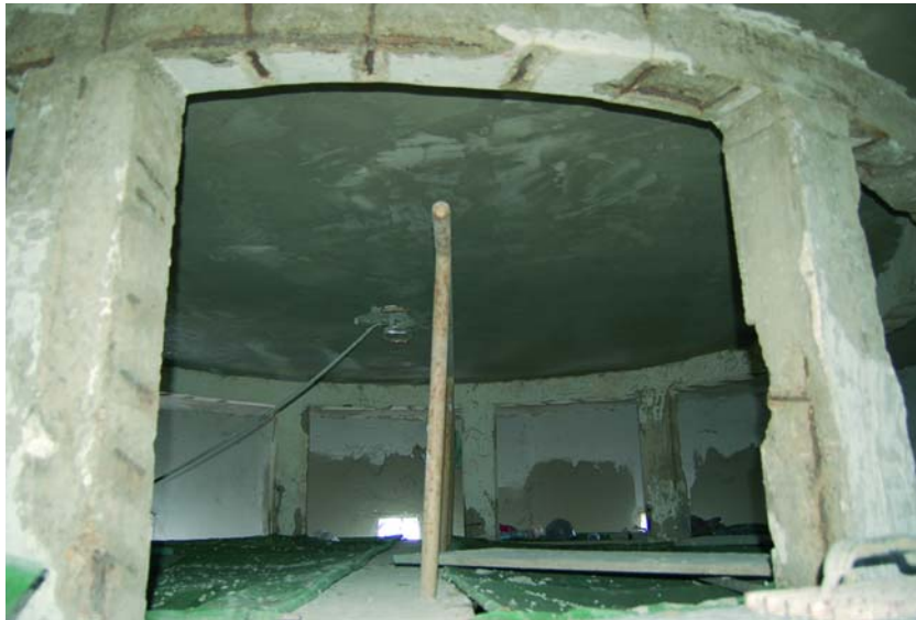
A víztartály felső szintjének felújítása
