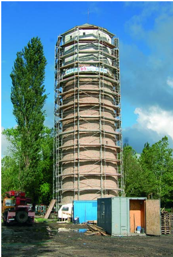
A téglahomlokzat elhasználódott elemeit pótolni kellett
