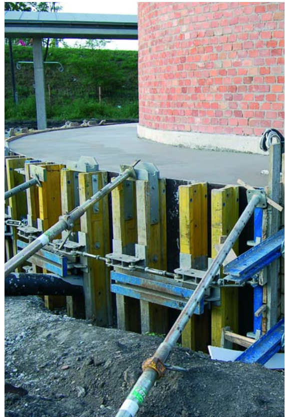
A víztorony alap megerősítése
