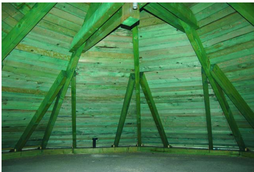
A víztorony fedélszéke is új faborítást kapott
