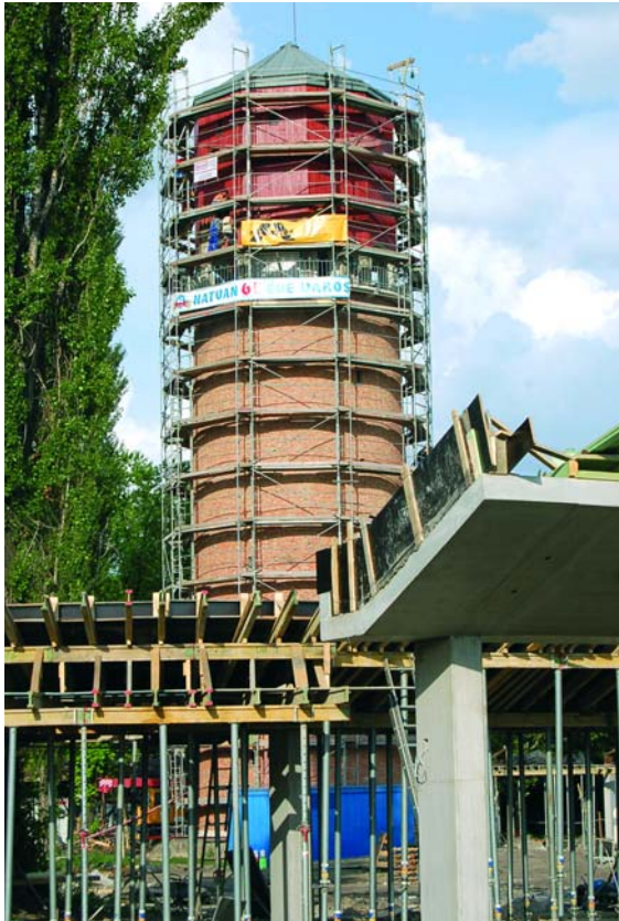
A 35 méter magas víztorony csőállványzatának felépítése
