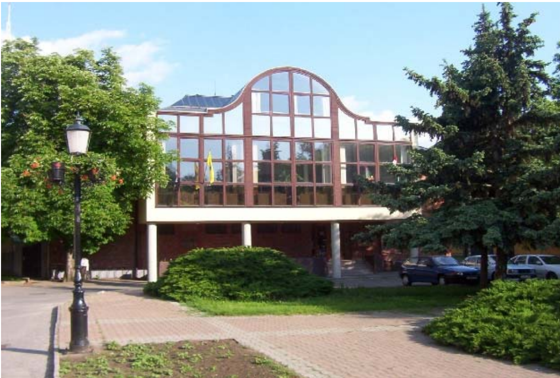
A bibliotéka épületének 1993-2019. közötti homlokzata
