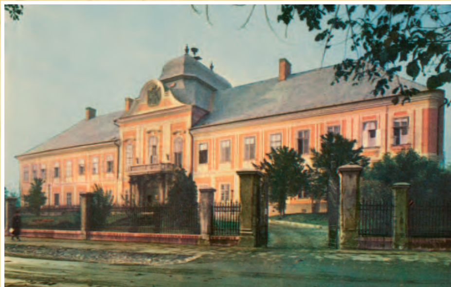
(040.) Az egytraktusos, folyosós rendszerű kastélyépület 62 méter hosszú, teljes egészében alapincézett. Az épületszárnyak hossza 35 méter, a kastély alapterülete pedig 1500 négyzetméter. The single span building with corridors is 62 meters in length and there are cellars under the whole edifice. The side-wings are 35 m long, and the manor house has a basic area of 1500 m 2 .
